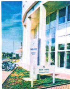
Nicht zu übersehen - die Außenstelle Grünau der Stadtverwaltung.
